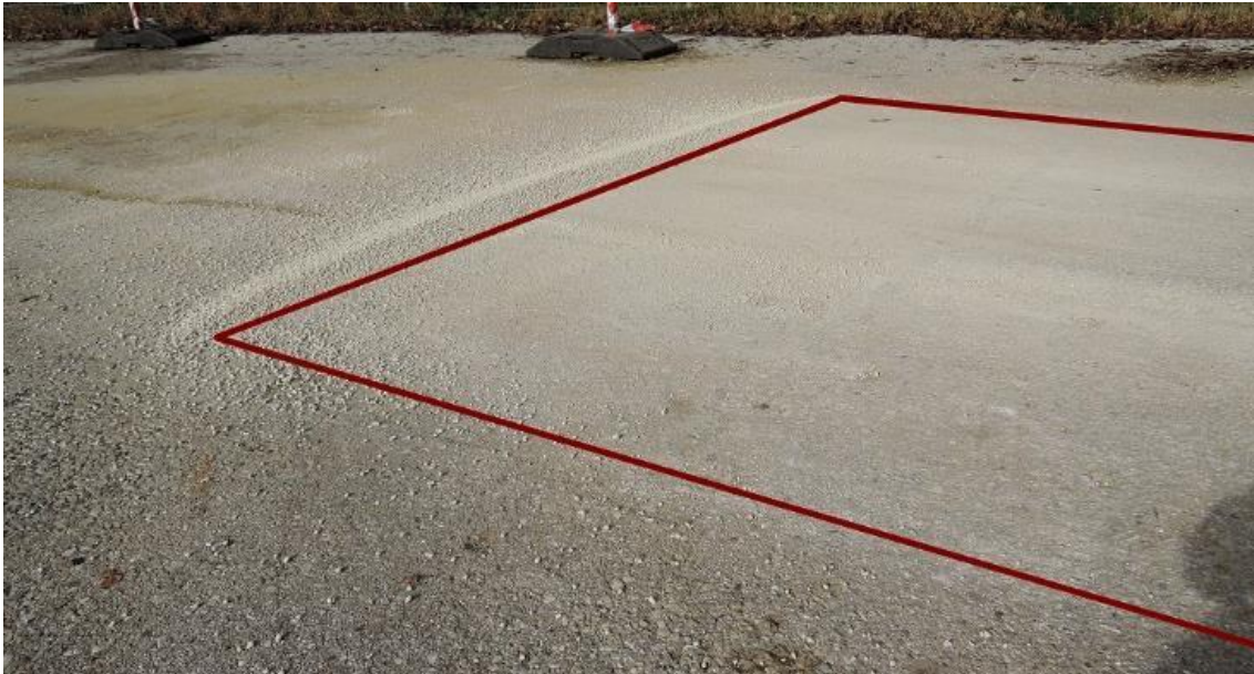
Abbildung 66: Trockenschüttung nach Räumfahrt
