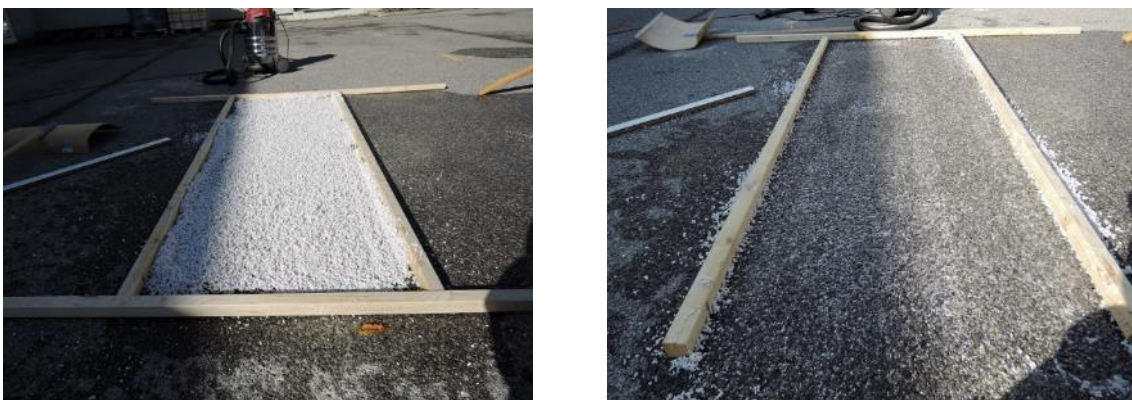
Abbildung 65: befeuchtete Wärmedämmschüttung als Schneersatzmaterial
